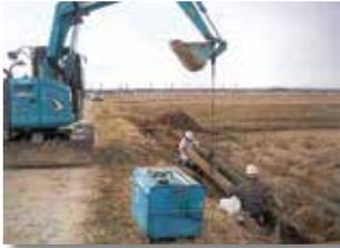
漏水する溝畔の補修
