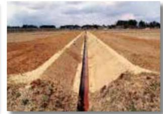
沈下した用水路の布設替え
