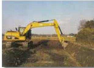
用水路漏水処理の暗渠排水管の設置
